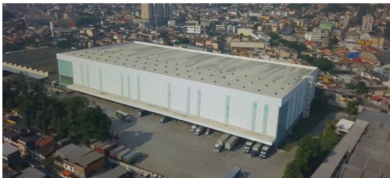
Centro de distribuição no Rio de Janeiro (RJ)
